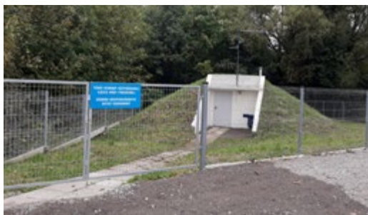
Ujęcie wody S1 w Sadowiu
