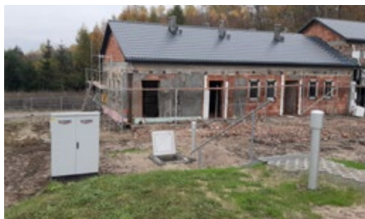
Ujęcie wody w Rawałowicach
