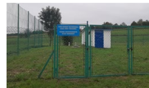
Ujęcie wody G1 w Goszczy
