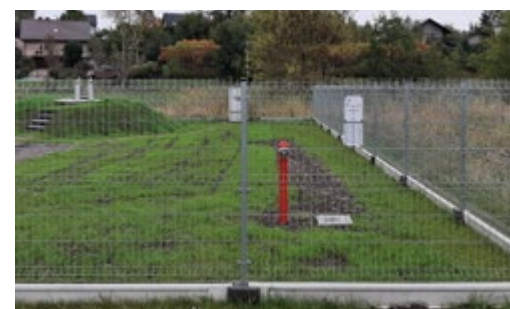
Ujęcie wody L3 w Łuczycach
