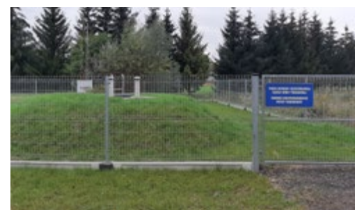
Ujęcie wody L1 w Łuczycach
