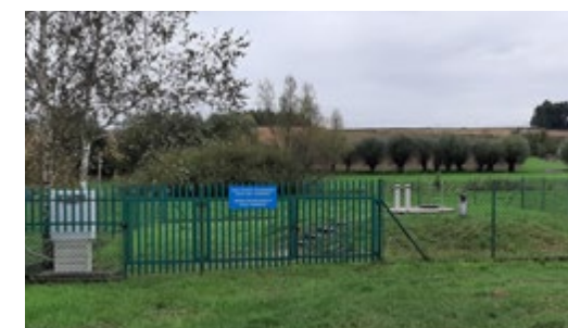
Ujęcie wody L2 w Łuczycach
